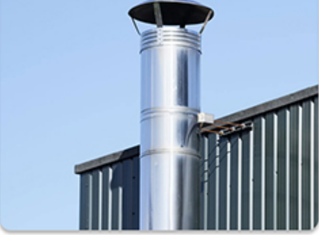
DOĞALGAZ BACA SİST.
