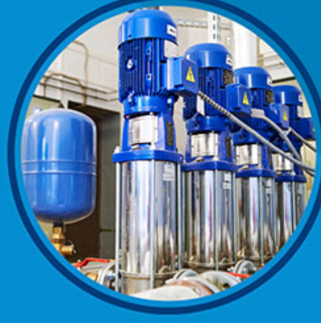
Pompa & Hidrofor Sist.
